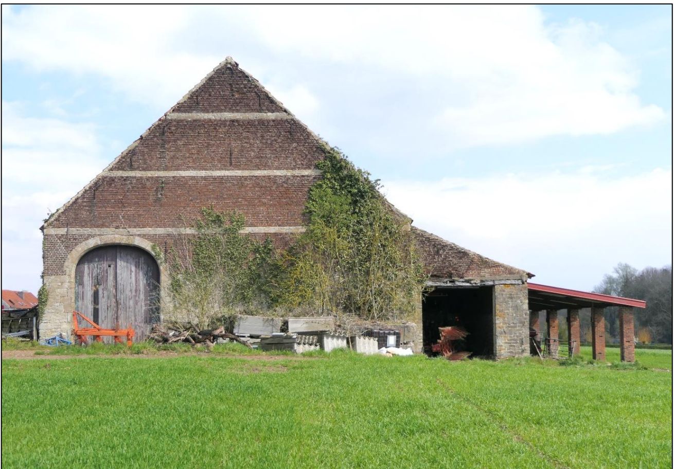
De westgevel met de gemetselde speklagen boven de poort, rechts het hok en het afdak – foto 12.04.2021.
