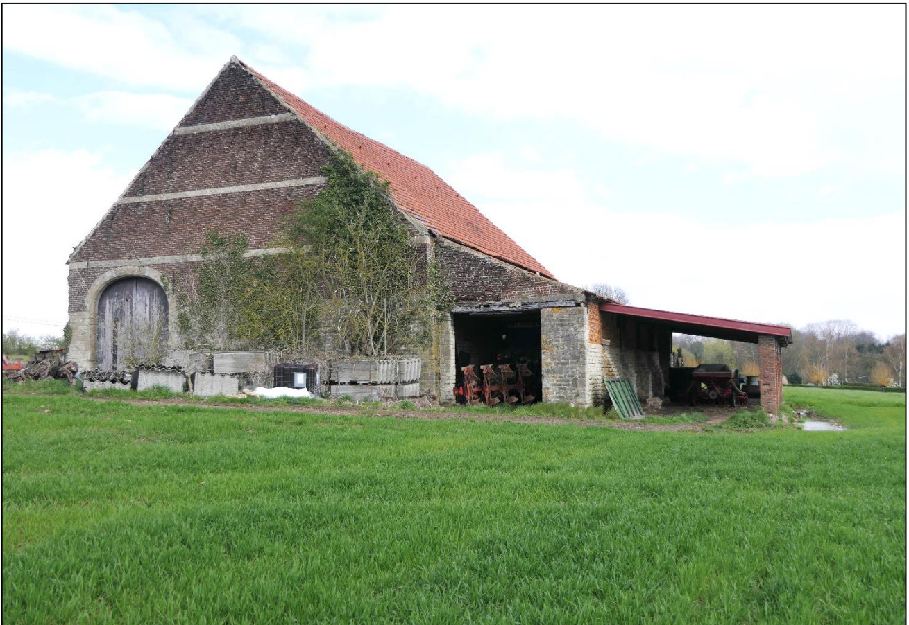
De westgevel met de zuidmuur, waar een hok werd gemaakt en een afdak werd bijgebouwd. De onderkant van de oorspronkelijke zuidmuur (dus aan de buitenkant van het hok onder het afdak) is nog aanwezig met restanten van 4 steunberen – foto 12.04.2021.
