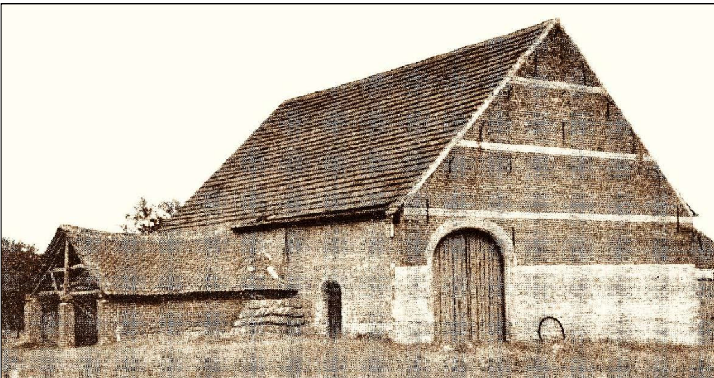
Oude foto van de westgevel (met het al verlaagde dak, dus nà 1923), met links een duidelijker zicht op het grote karrenhuis aan de noordmuur. (zie ook de foto op blz. 49).
