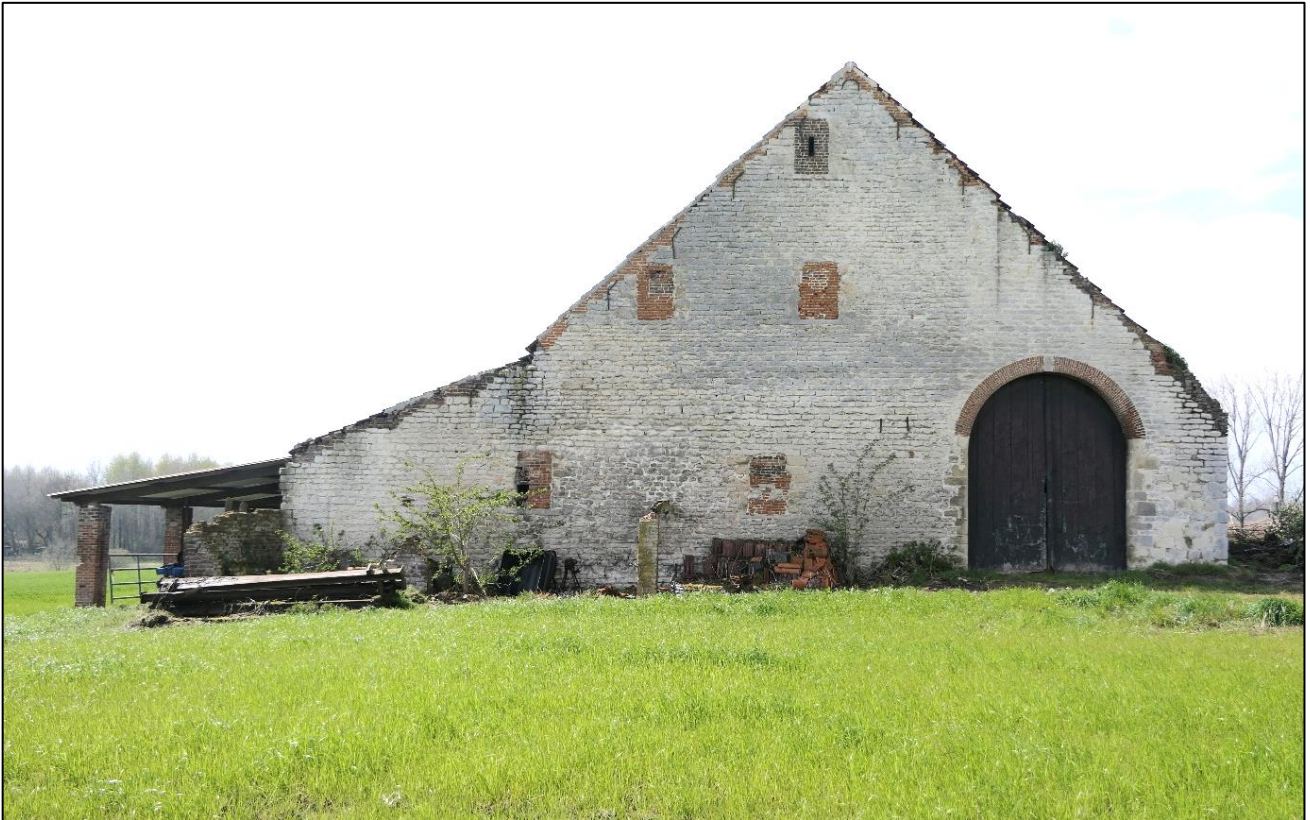
De oostgevel van de Duivelsschuur met de dichtgemetselde ramen. De "vreemde" en onlogische plaats van deze ramen in de huidige gevel is perfect te verklaren door de uitgevoerde verbouwing van 1919 – 1923 [zie overlappende foto's op blz. 17] – foto 12.04.2021.
