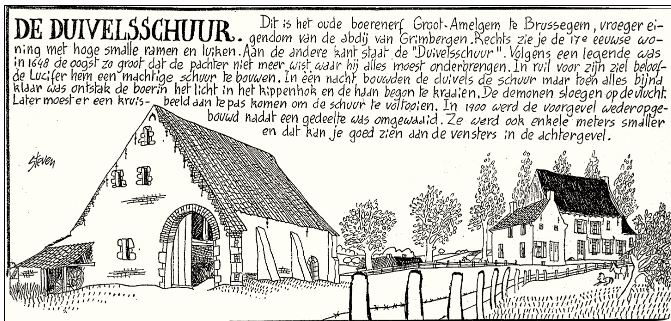
Tekening van Stefan Wilsens voor de dagbladen van de Standaardgroep dd. 05.11.1970. De gegevens in de tekst zijn niet helemaal correct, maar de tekening toont wel aan dat het kleine hok (dan half open) aan de linkerkant van de oostgevel er toen nog stond, en dat in 1970 het karrenhuis aan de noordmuur al verdwenen was.
