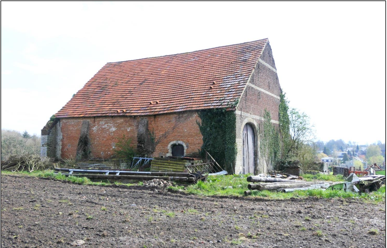
De westgevel met de noordmuur, met in die laatste de deur en de twee steunberen— foto 12.04.2021.
